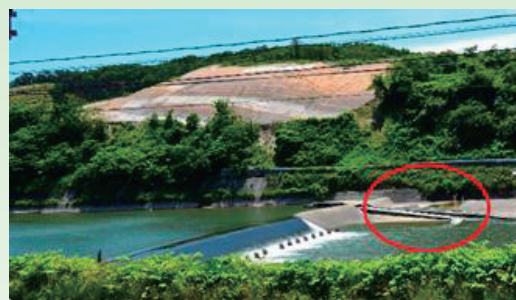
新第二床固 山地部掘削作業 ○印は現在の第二床固の魚道
